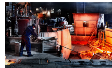
ANODENOFEN MIT GIEßANLAGEN
